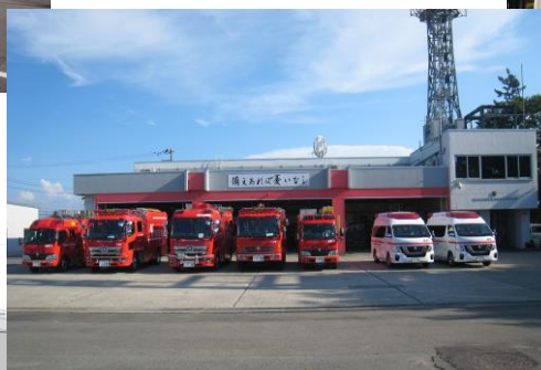
消防本部・消防署庁舎
