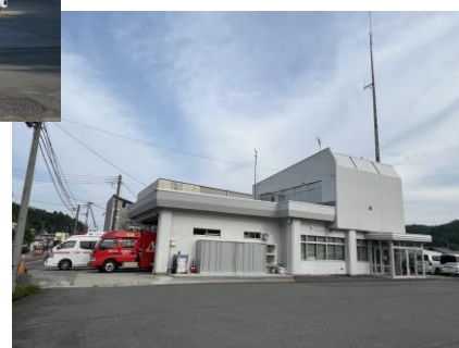
西川分署庁舎
